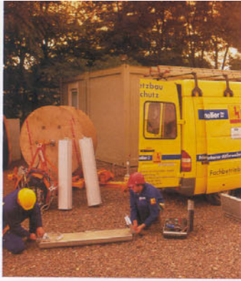
Vorbereitungen für den Funknetzbau
