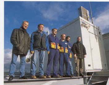
Das Team für Funknetzbau der Firma Elektro Tonnellier auf dem Dach eines Hochhauses.
