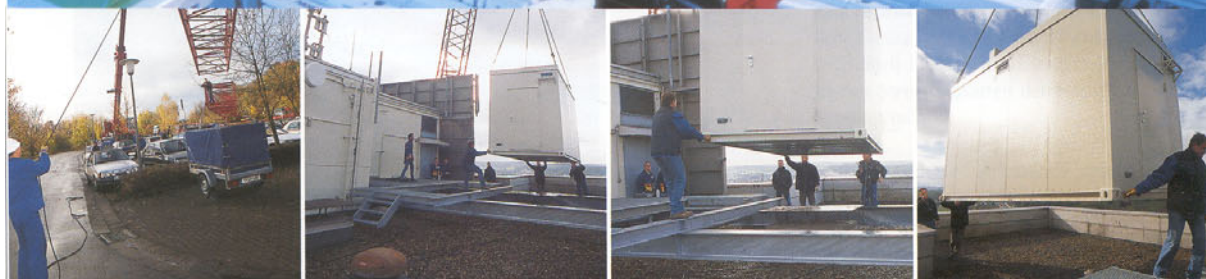
Elektrotechniker beim Verteilungsbau (Rene Spingardi)
